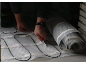
Резка сетки (кабель не режется)
